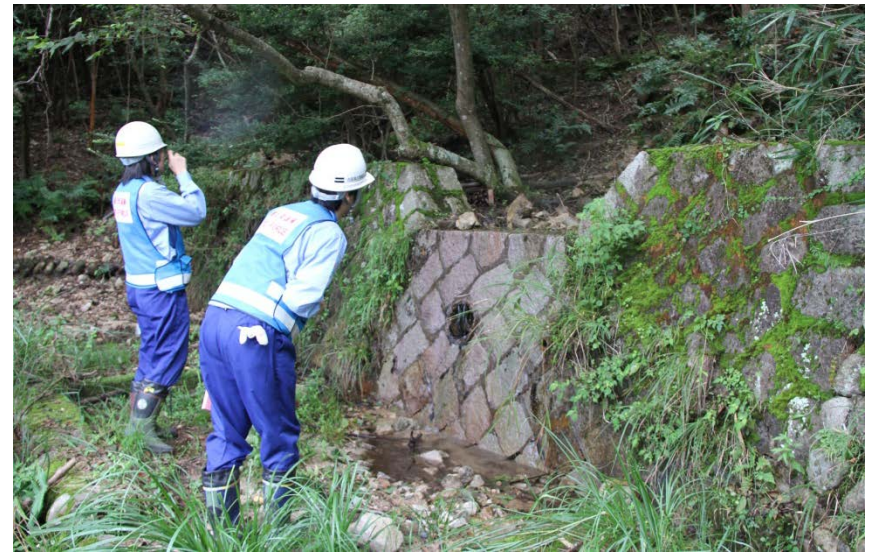
溪流点検調査
