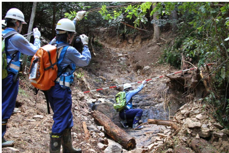
溪流点検調査
