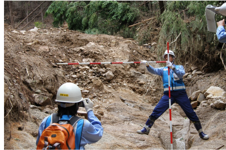
溪流点検調査
