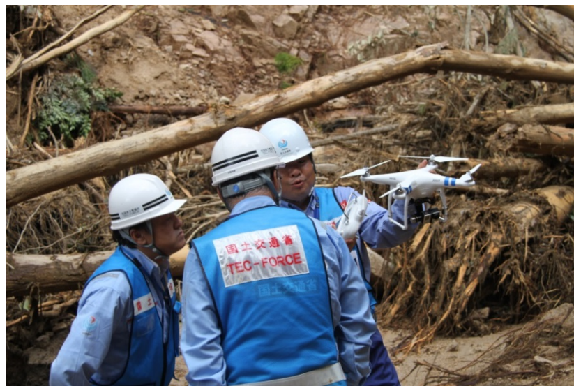
ラジコンヘリ（九州TEC所有）との共同調査
