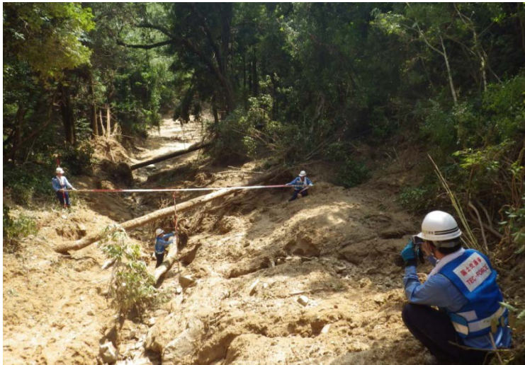
溪流点検調査
