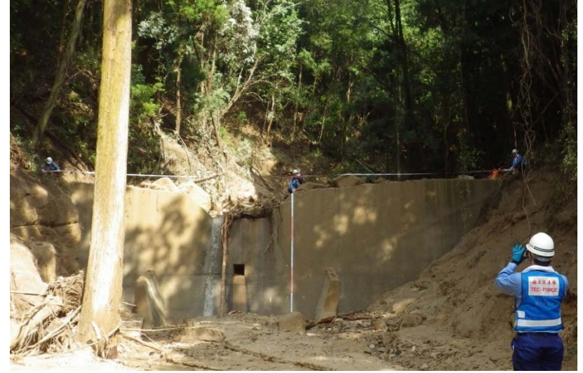
溪流点検調査
