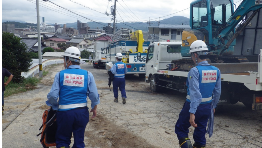
現地調査箇所の確認
