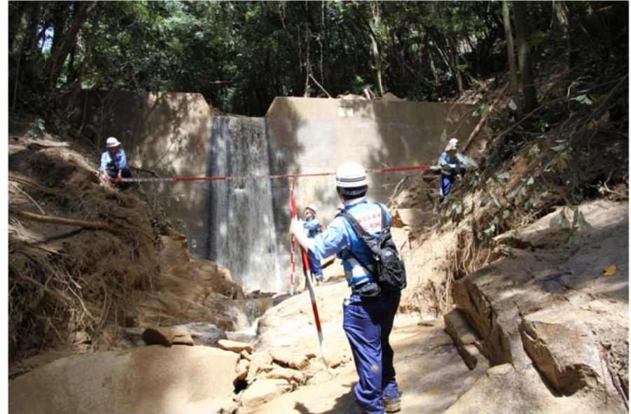
溪流点検調査
