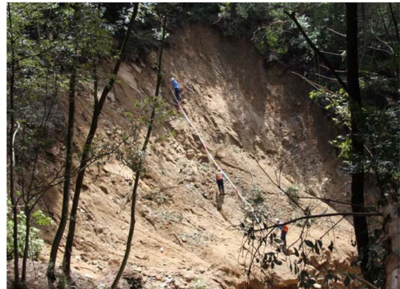
溪流点検調査 (土砂崩落箇所)
