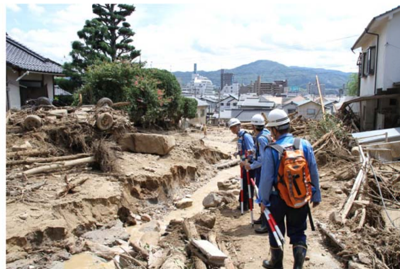
現地調査箇所周辺地区の被災状況
