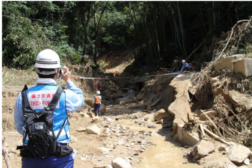
溪流点検調査 (流路状況)
