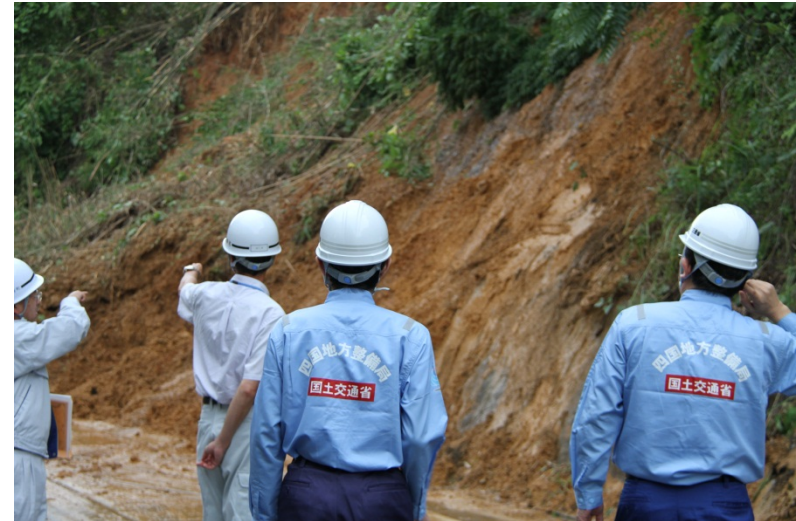
法面の被災状況確認
