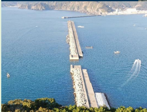
▲東防波堤の全景
