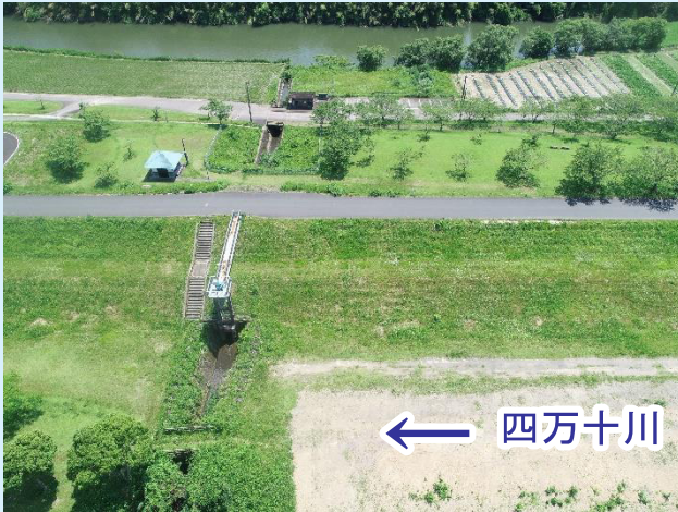
【整備前 令和2年6月】
