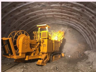
【トンネルの掘削】
