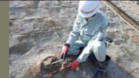
F：動物の掘返しによる変状
