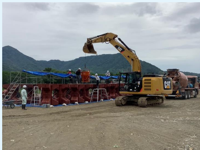
根固めブロック製作状況
