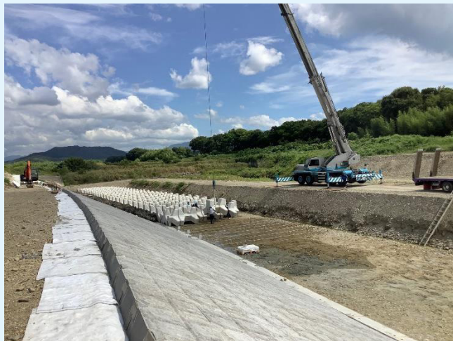
根固めブロック設置状況
