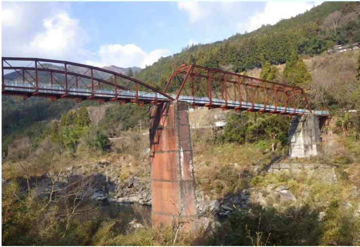
(旧)吉野川橋(大豊町)【明治44年完成】 ※現存の道路トラス(原位置)としては国内最古
