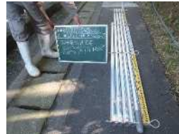
【挿入式孔内傾斜計】
