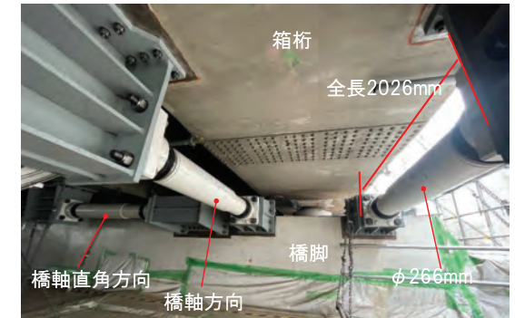
(b) 設置完了の詳細
