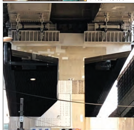
(d) 設置完了の全景
