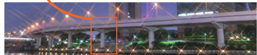
首都高速6号向島線 (RC造単柱橋脚)
