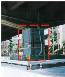
コンクリート橋脚へ鋼板巻き立て
