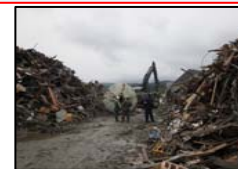
〔道路啓開状況〕
