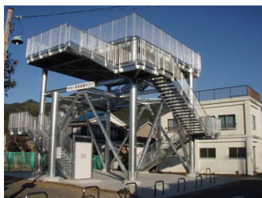
◇津波避難タワー(徳島県海陽町)
