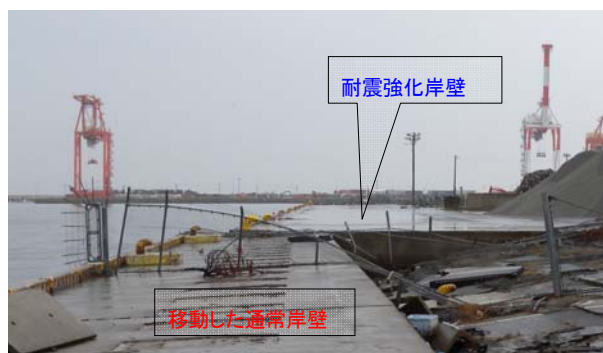
◇耐震強化岸壁(仙台塩釜港 仙台港区)
