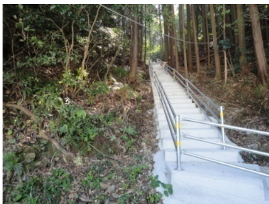
◇東海小学校背後の急傾斜地を 活用した避難階段(愛南町)
