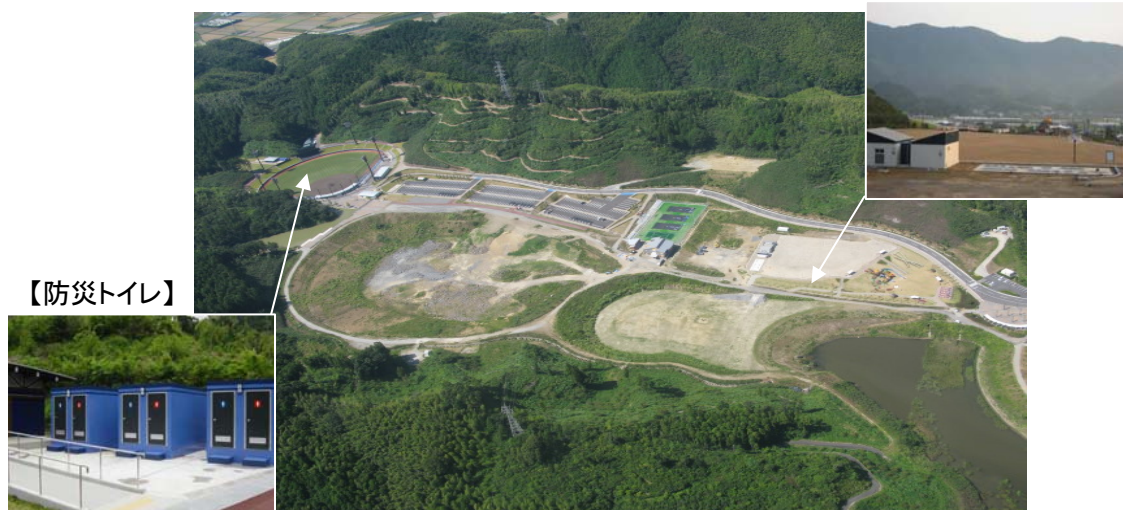
◇ 防災拠点としても活用されるよう整備された施設(阿南市南部健康運動公園)
