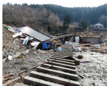
鉄道の被害(大船渡市)
