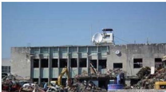
庁舎の被害(大槌町)
