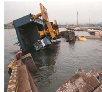
荷役機械の転落(相馬市)
