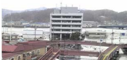
庁舎の被害(宮古市)
