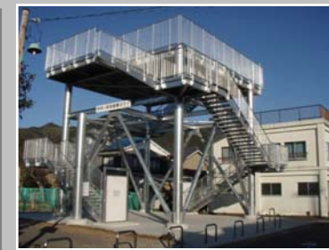
・津波避難タワーの整備
