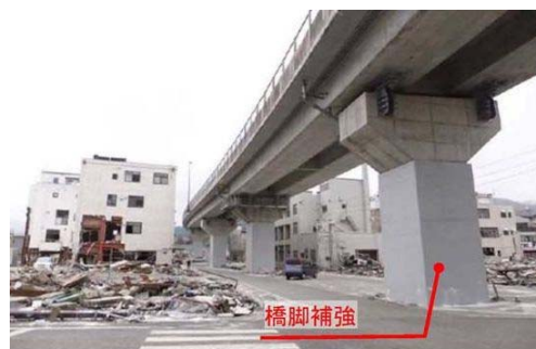
【耐震補強済み(鋼板巻立補強)】 地震動により損傷なし
