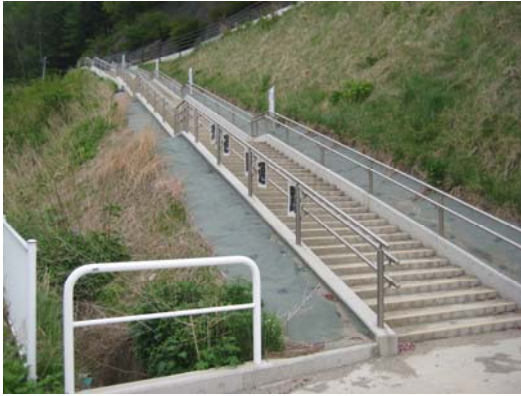
◇国道45号に配置された、小本小学校 津波避難階段（岩手県岩泉町）
