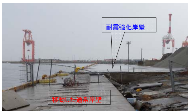
◇耐震強化岸壁(仙台塩釜港 仙台港区)
