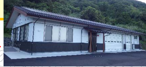
指定避難所 防災コミュニティーセンター
