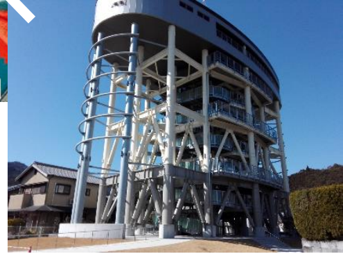
※浜町地区にある津波避難タワー
