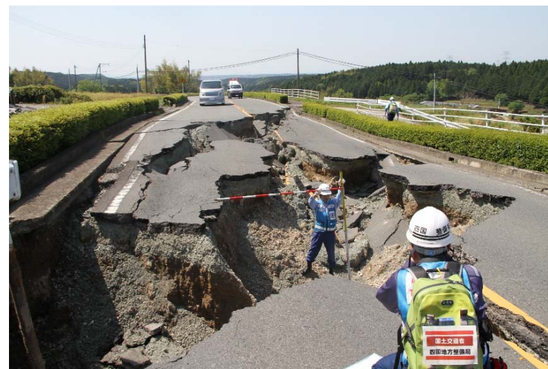
県道28号線の陥没状況を調査する隊員(西原村)
