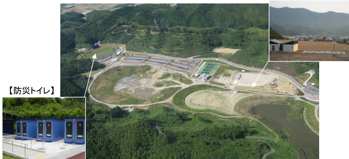
◇ 防災拠点としても活用されるよう整備された施設(阿南市南部健康運動公園)
