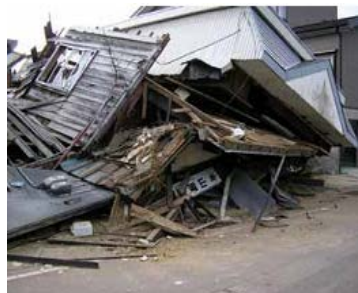
倒壊した家屋(長岡市)
