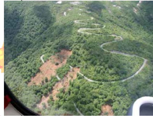
法面崩落(岩手県栗原市) H20岩手・宮城内陸地震
