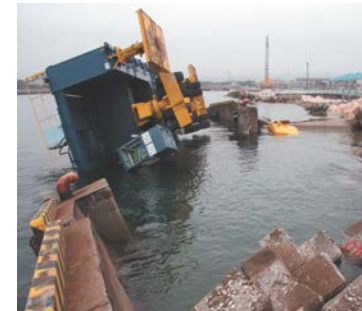
荷役機械の転落(相馬市)
