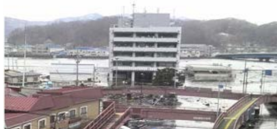
庁舎の被害(宮古市)
