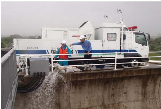
排水ポンプ車の設置
