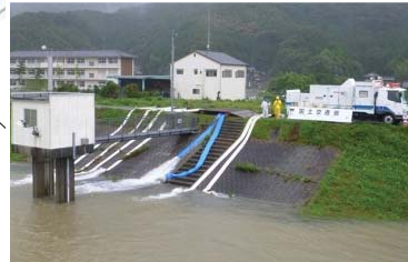
排水ポンプ車による排水運転 四万十市(榎沢樋門)
