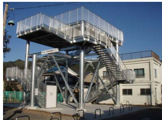
◇津波避難タワー(徳島県海陽町)
