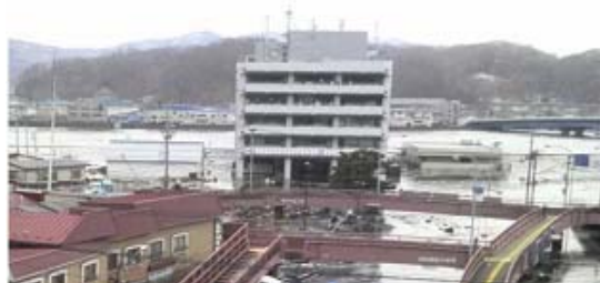
庁舎の被害(宮古市)
