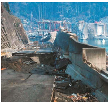
道路の被害(釜石市)
