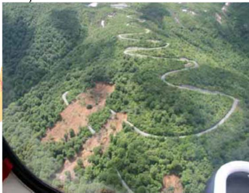
法面崩落(岩手県栗原市) H20岩手・宮城内陸地震
