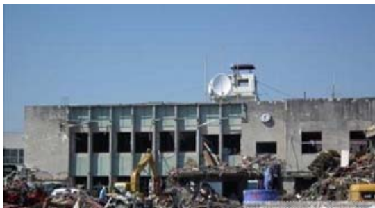
庁舎の被害(大槌町)
