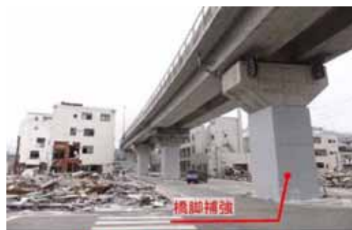
◇橋脚耐震補強(国道45号)
