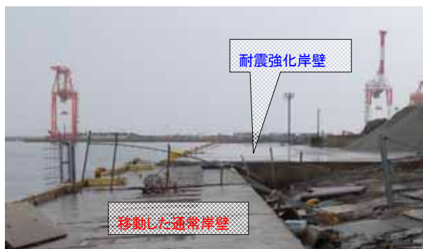
◇耐震強化岸壁(仙台塩釜港 仙台港区)
