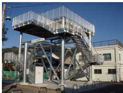
◇津波避難タワー（徳島県海陽町）
