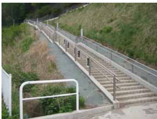
◇国道45号に配置された、小本小学校 津波避難階段（岩手県岩泉町）
