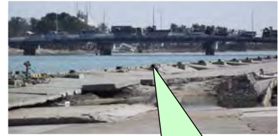
橋梁上（一般車通行止め）は瓦礫を運ぶ車両の列
