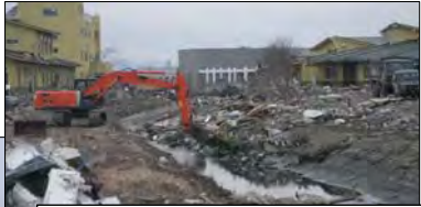
瓦礫の撤去状況(名取市関上[ゆりあげ]地区)
