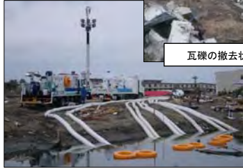
排水ポンプ車による排水状況(名取市関上[ゆりあげ]地区)
