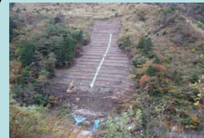
山腹工・山腹保育工
