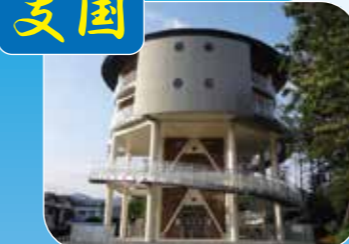
津波避難タワー(中土佐町)
