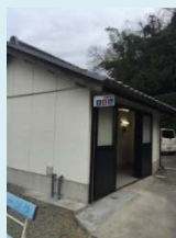
甲山寺境内トイレ
