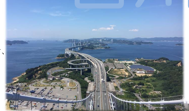
JR瀬戸大橋線が真横を駆け抜ける管理路
