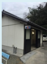
甲山寺境内トイレ
