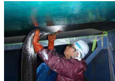
写真9 橋梁の修繕状況
