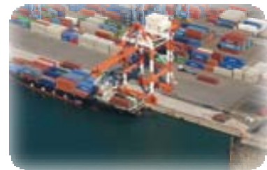
写真5 松山港国際物流ターミナル (愛媛県松山市)
