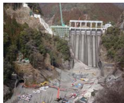
写真2 長安ロダム改造事業 (徳島県那賀町)
