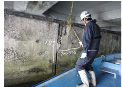
写真8 構造物の点検状況
