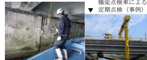
▲栈橋下面部の定期点検（事例）
