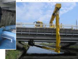
橋梁点検車による定期点検（事例）
