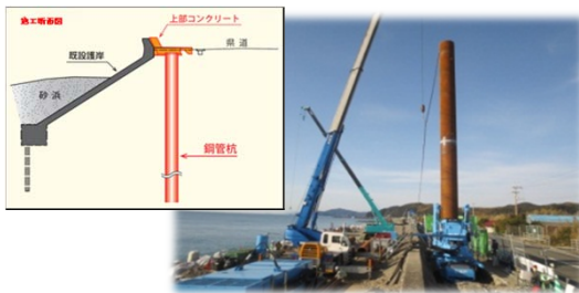
▲海岸堤防の補強（事例）
