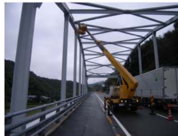
▼高所作業車による定期点検
