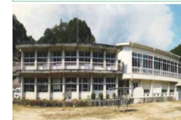
▲廃校を利用した集落活動センター（高知県黒潮町）
