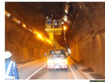
▲トンネルの定期点検
