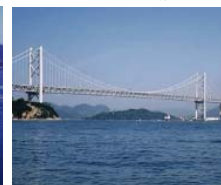
▼明石海峡大橋
