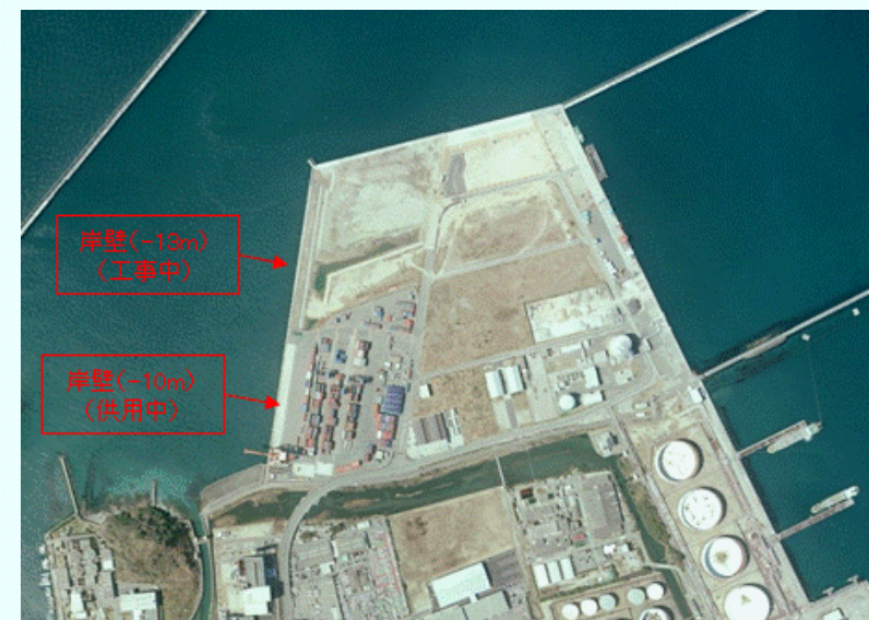
整備が進む松山港外港地区
