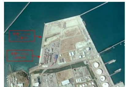
整備が進む松山港外港地区
