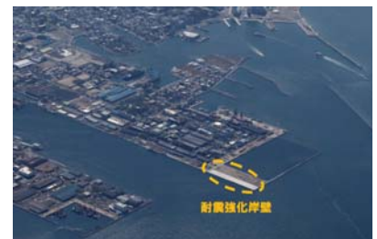
高松港 耐震強化岸壁
