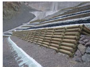
森林土木工事における四国産材の利用(木製土留工 徳島県那賀町)
