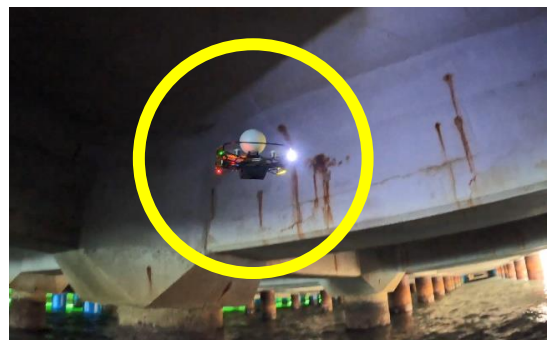
写真3-2 空中ドローンによる撮影状況
