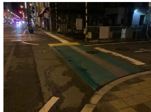
写真-11 施工後（市道側）
