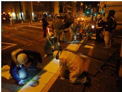
写真-6 踏切内の施工状況
