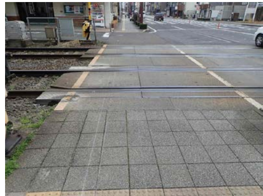
写真-8 施工前（踏切側）
