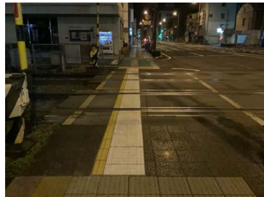
写真-9 施工後（踏切側）
