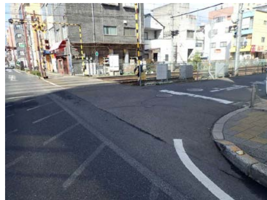
写真-10 施工前（市道側）
