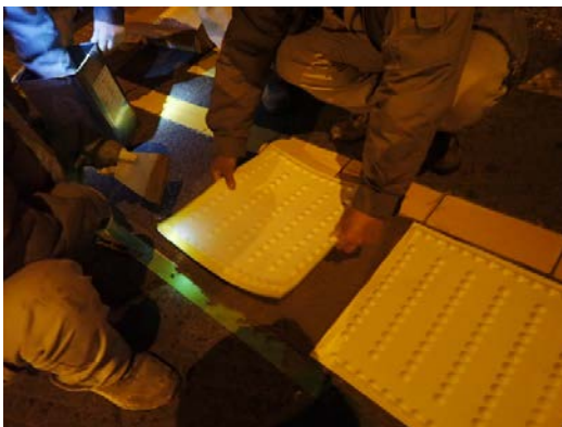
写真-7 エスコートゾーン張り付け状況
