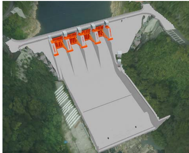
図-4 レーザ測量データからモデル化（新宮ダム）
