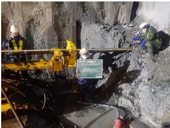
図-2 坑内水平ボーリングの様子
