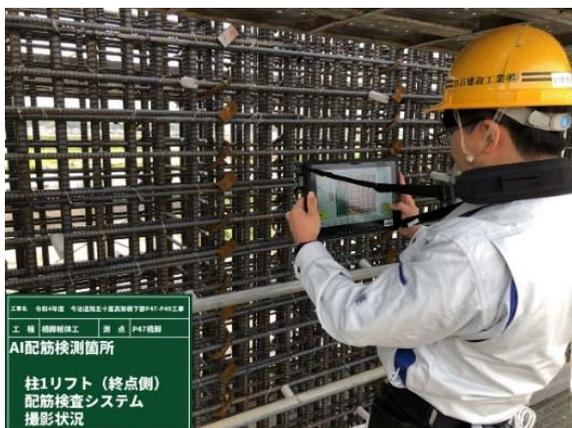
図4 配筋検査システムによる実施状況
