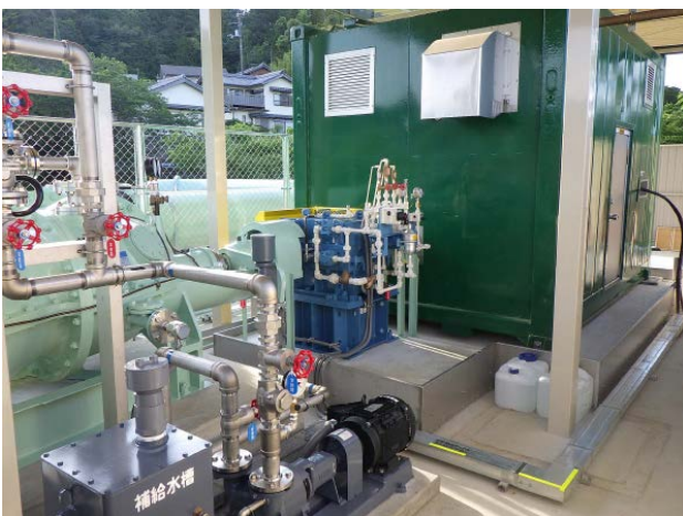
写真-6 エンジンパッケージ設置状況
