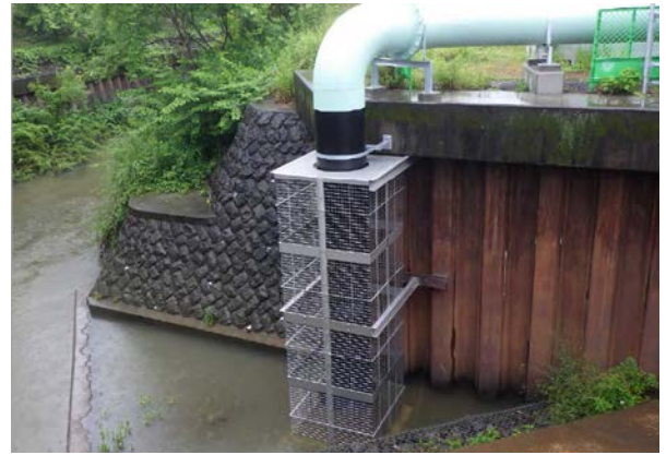
写真-7 吸水管ストレーナ設置状況
