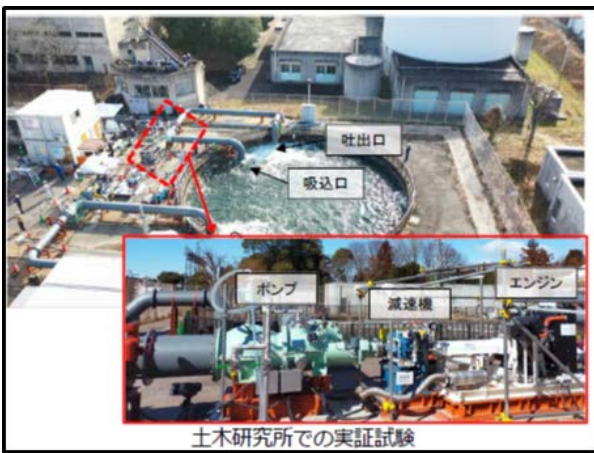
写真－1 土木研究所構内での実証試験状況
