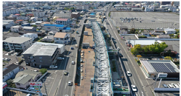
写真1 徳島東環状線の現在の状況
